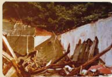
Eingestürzter Gemeindesaal in der Bahnhofstraße 1981
